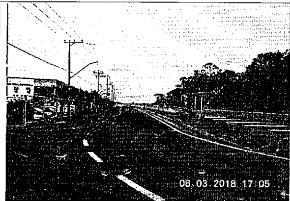
Foto 3: Vista frontal da via a ser denominada.
