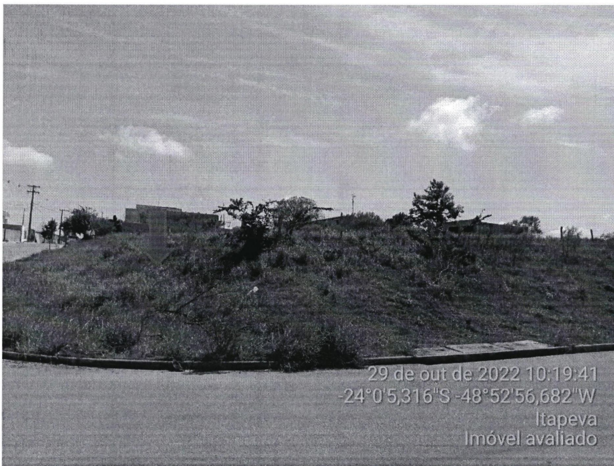
Foto 14 – Área avaliada – “Sistema de lazer” Autor: DIAS BUENO ENGENHARIA E SERVIÇOS LTDA (2022)
