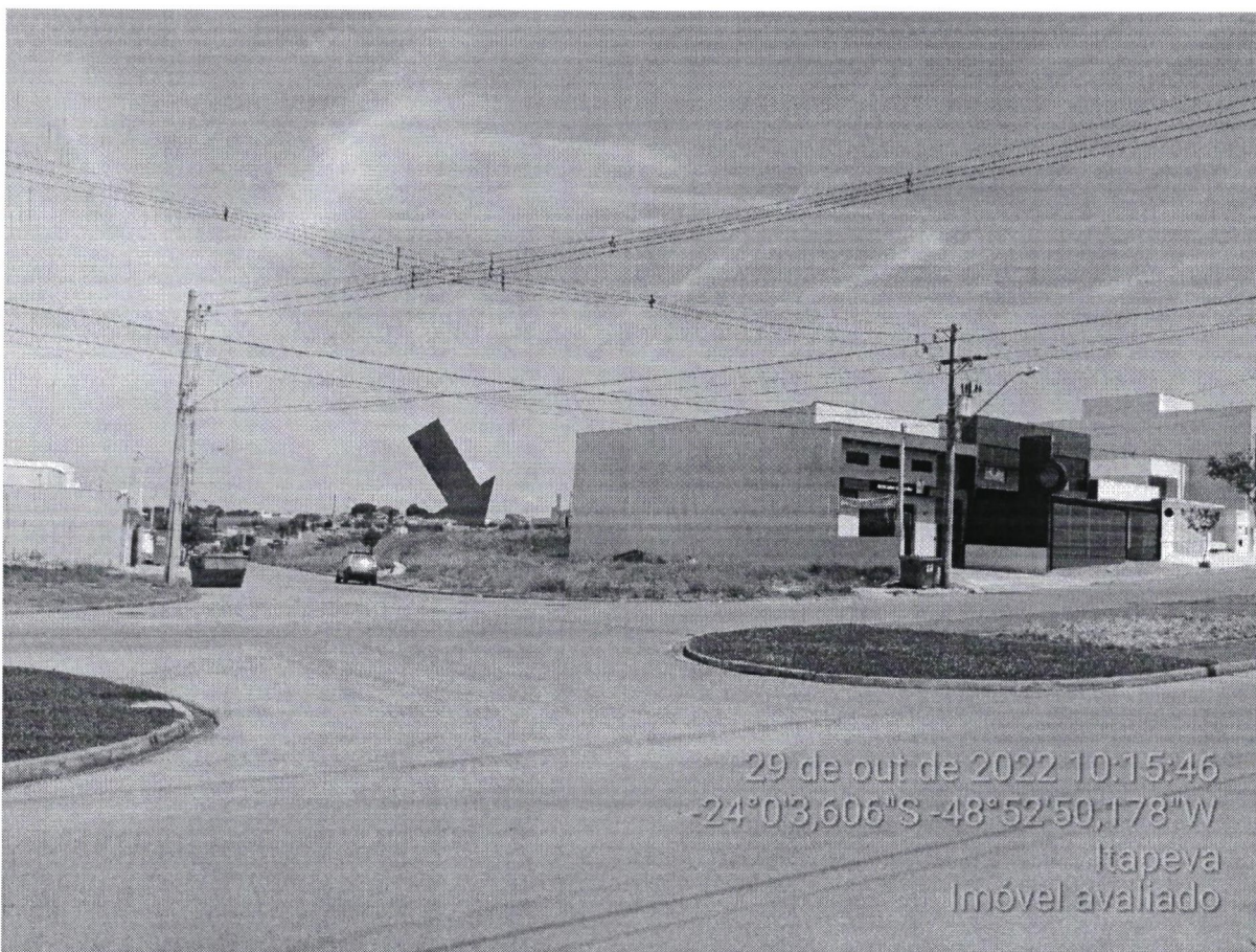
Foto 08 – Área avaliada – “Área Institucional” Autor: DIAS BUENO ENGENHARIA E SERVIÇOS LTDA (2022)
