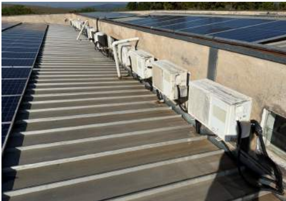
Figura 14 - Telhado do bloco dos gabinetes GB2
