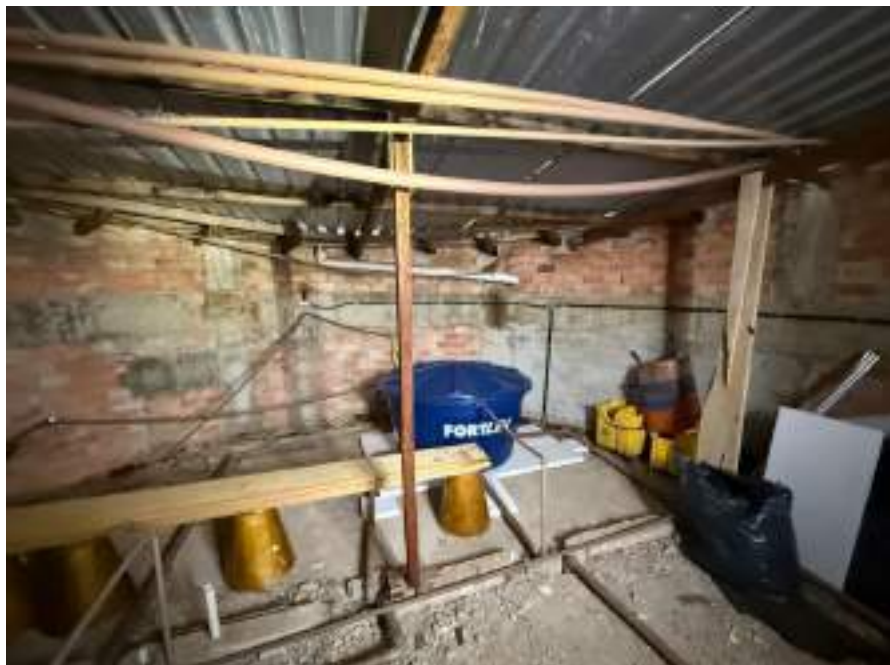
Figura 39 - Estrutura de madeira do telhado
