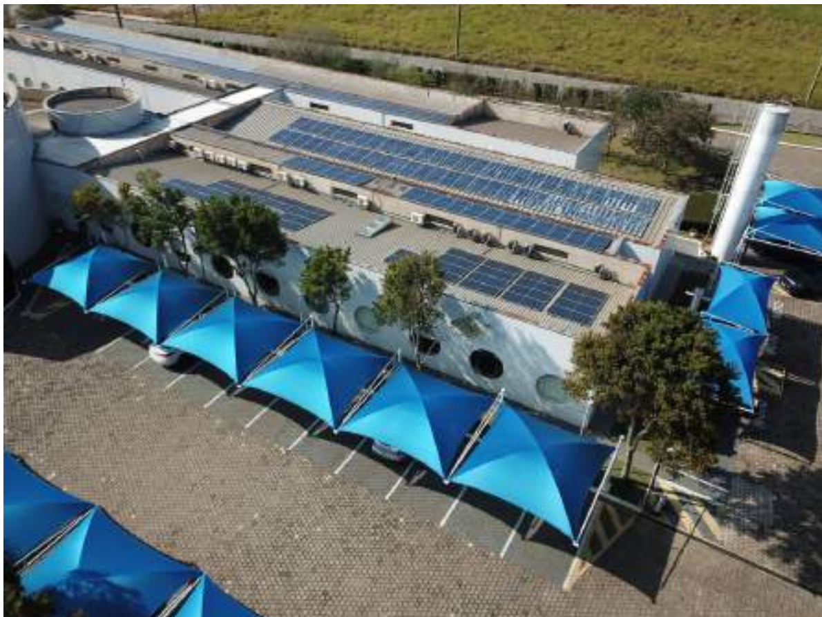
Figura 78 – Vista das 6 árvores próximo a edificação que geram detritos
