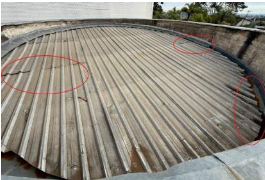
Figura 38 - Cobertura sobre o banheiro e barrilete - bloco PL3
