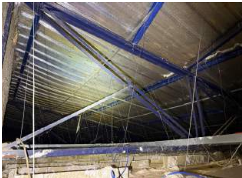
Figura 44 - Estrutura de cobertura em aço do bloco PL2
