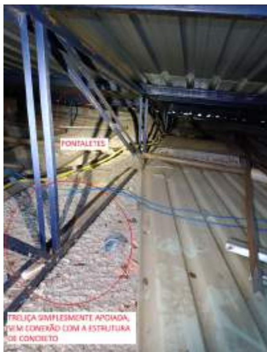
Figura 12 - Estrutura de cobertura do bloco GB1
