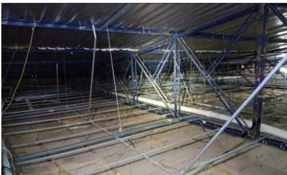
Figura 49 - Estrutura de cobertura do bloco do plenário PL1
