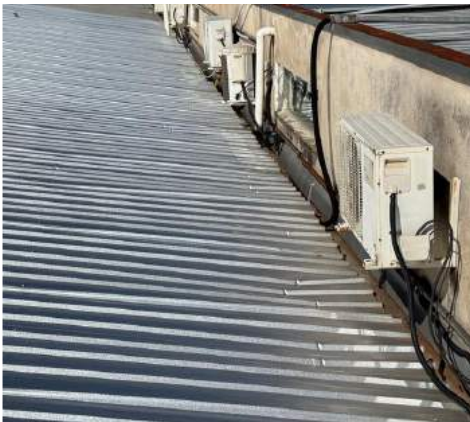
Figura 26 - Telhas adicionados sobre as existentes - Bloco ADM2
