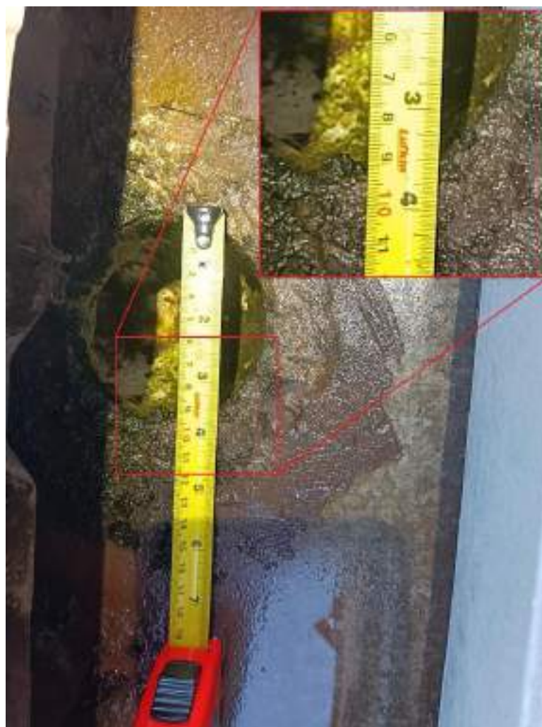
Figura 8 - Entrada do condutor vertical pluvial, diâmetro próximo a 100mm - Bloco GB1
