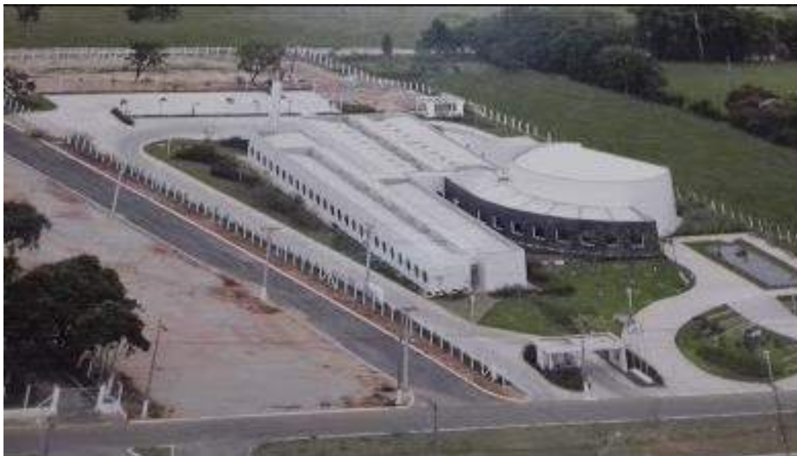
Figura 2 – Foto área após a inauguração com telhas de fibrocimento.
