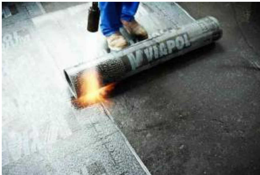
Figura 75 - Exemplo de aplicação de manta sobre laje
